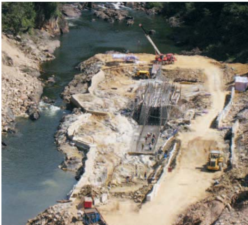
En mai 2007, la construction, au coût de 53 millions $ US, de la centrale hydroélectrique Vaca d'une capacité de 18 MW a commencé à environ cinq kilomètres en aval de Mollejon sur la rivière Macal, au Belize.
