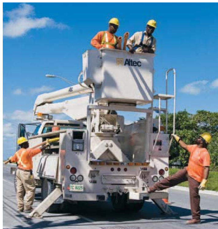
Fortis Turks and Caicos a une capacité de production combinée alimentée au diesel de 48 MW, et a répondu à une demande combinée de pointe de 28 MW en 2007.
