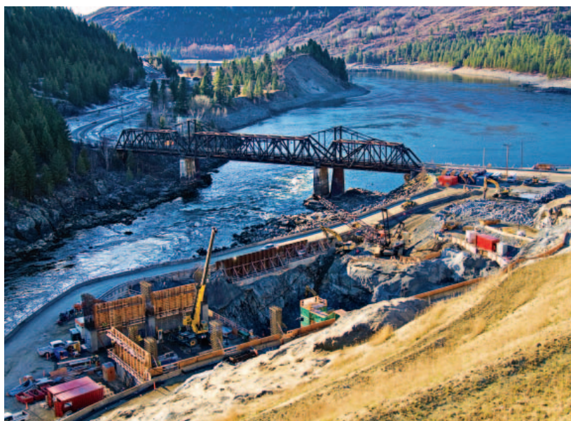
Les travaux de construction de la centrale hydroélectrique Expansion Waneta de 335 MW, au coût de 900 millions $, vont bon train.
