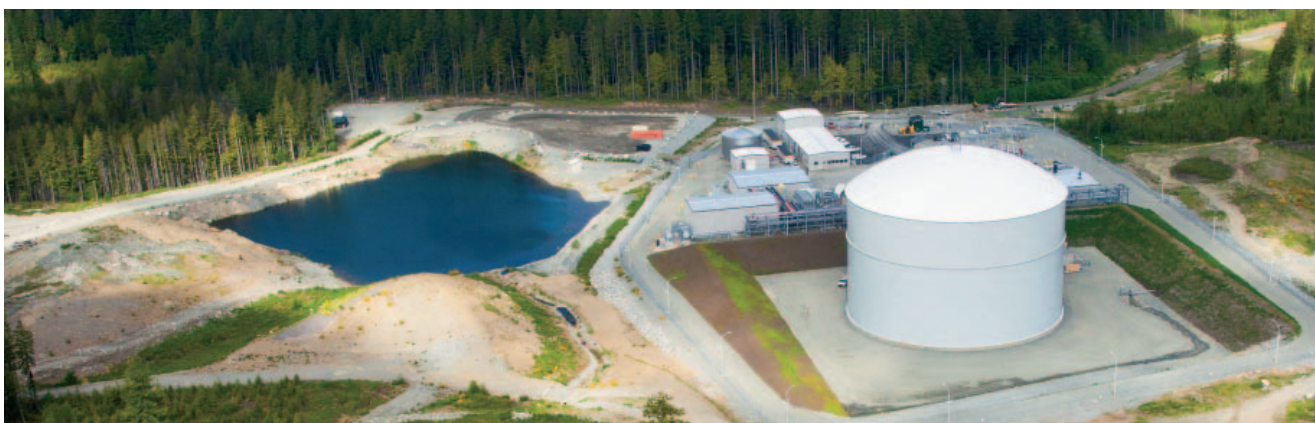
Les travaux de construction de l'installation de stockage de gaz naturel liquéfié de 1,5 milliard de pieds cubes sur l'île de Vancouver, au coût de 212 millions $, ont été achevés en 2011.
